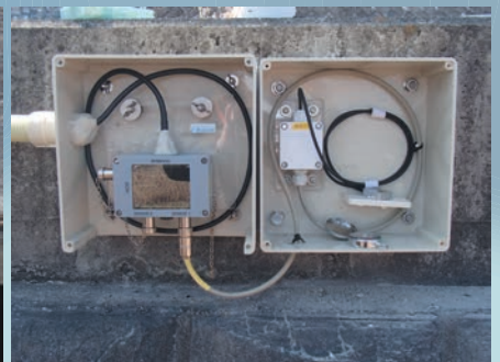
傾斜センサー設置状況
